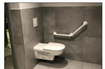
Un W.-C. installé plus haut, déporté et avec barre d'appui (type PMR). Photo ER
