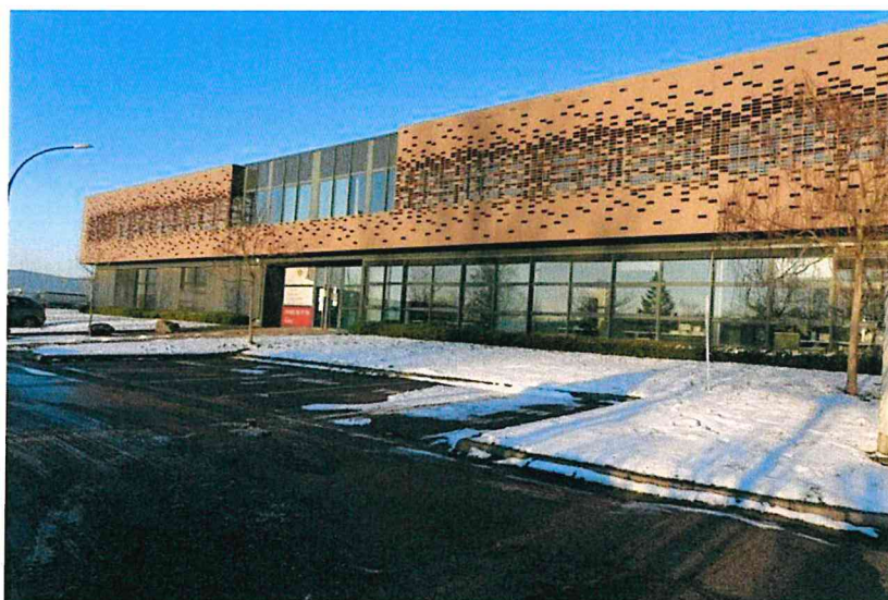
La pépinière hôtel d'entreprises implantée rue Lavoisier à Moncel-lès-Lunéville est gérée depuis 2019 par une filiale de la Chambre de commerce et d'industrie de Meurthe-et-Moselle Racine. Photo ER /C.C.
